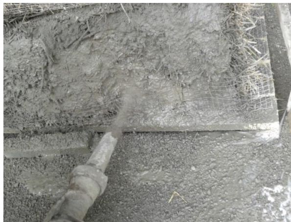
Рис. 1. Процес торкретування фрагменту солом'яної стіни
