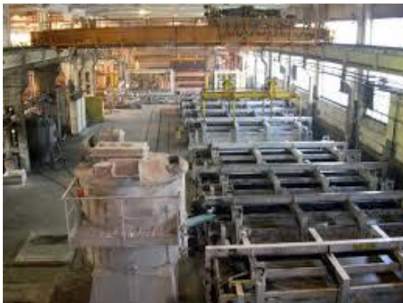
Рис. 7. Цех із виготовлення пінобетонних елементів
