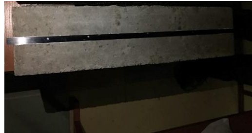
Рис. 4. Приклеювання композитної арматури
