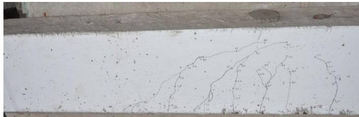
Рис. 2. Тріщини дослідних балкових зразків Бс-1 та Бс-2
