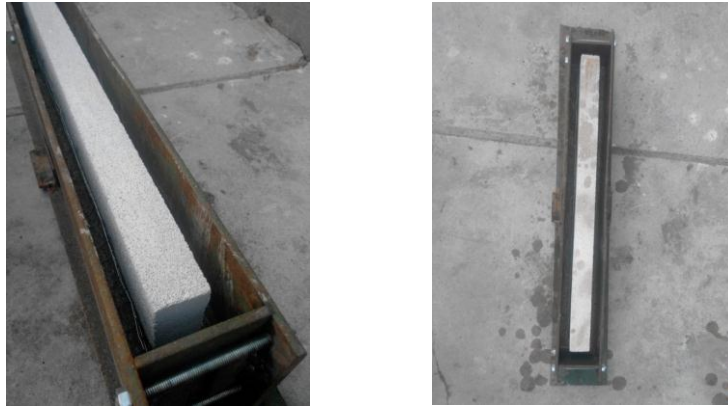
Рис. 1. Вкладання газобетонної балки у форму
