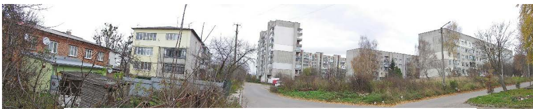
Рис. 1. Багатоквартирна забудова м. Дублян (фото А. Поліщука). Квартал багатоквартирної забудови (від двох до дев'яти поверхів).
