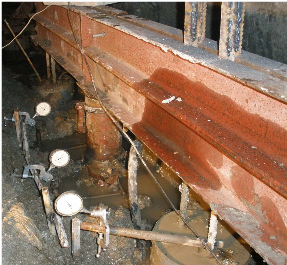
Рис. 2. Проведення експериментальних досліджень несучої здатності мікропалей на об'єкті влаштування фундаментів по вул. Козацькій, 18, м. Львові (ґрунт основи – жорстка осадкових порід).
