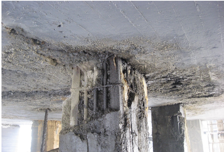
Рис. 5. Обпирання плити на колону опори П5/О4.
