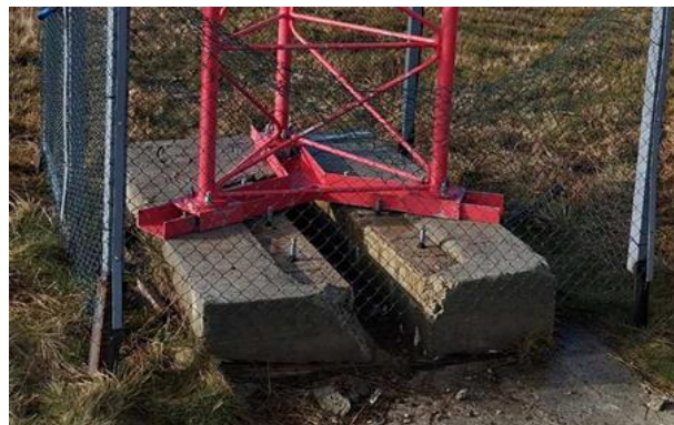
Рис. 2. Загальний вигляд надземної частини фундаменту
