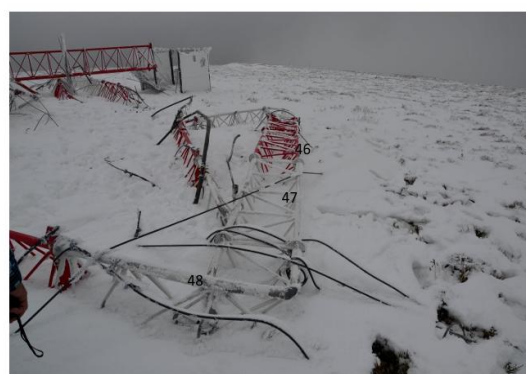
Рис. 12. Руйнування із згином секції 47 (ближній план)
