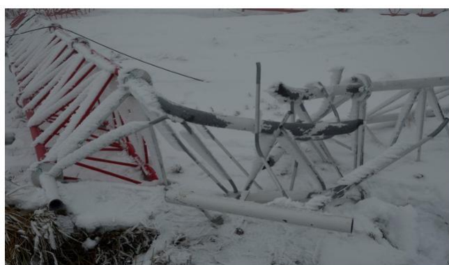
Рис. 10. Згин із зломом секції 19 (характерне прямолінійне руйнування труби у вигляді «зрізу»)
