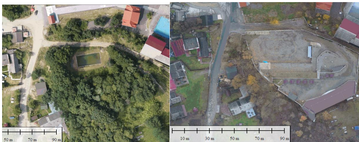
Рис. 9. Будівництво нового відпочинкового комплексу
