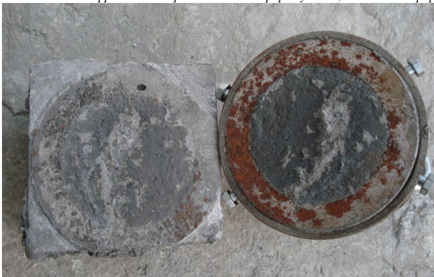
Рис. 2. Зовнішній вигляд, після розриву поверхні шорсткого бетону і торкретбетону
